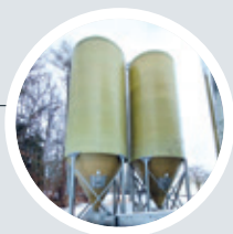
Silo av glasfiberförstärkt plast
